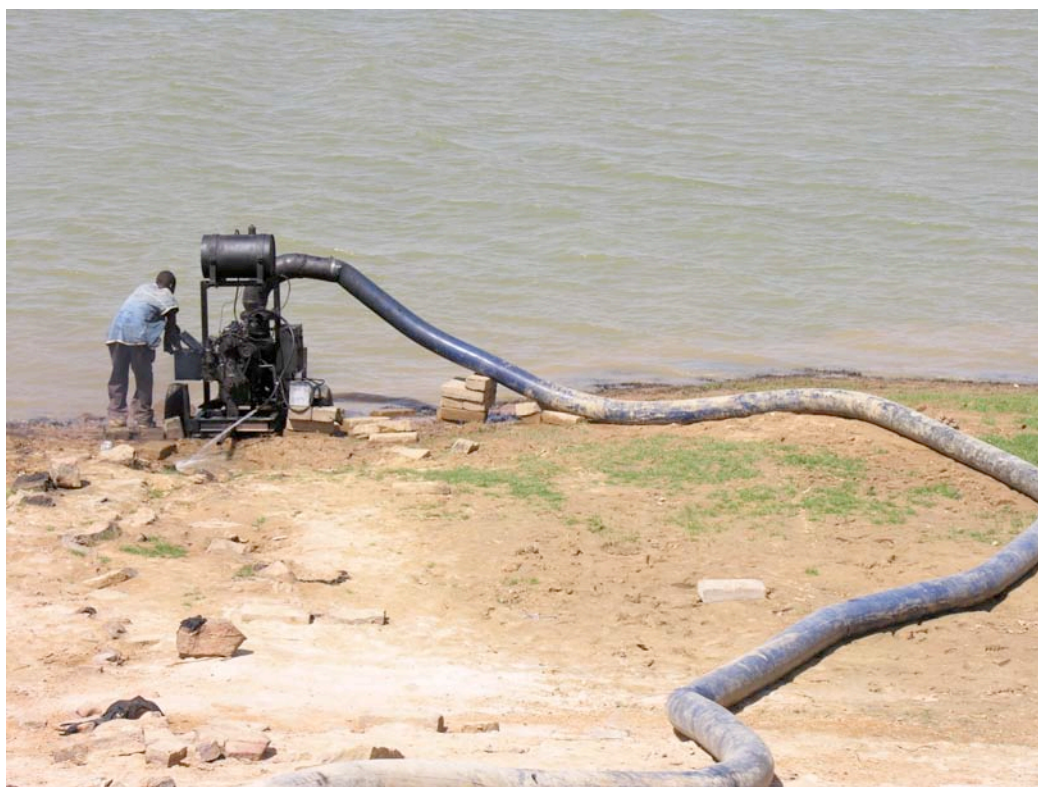
Pompe de la brigade de secours en intervention à Touara
